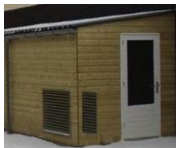
Figuur 6 Buitendeel in gevel fietsenschuur
