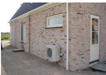
Figuur 5 Buitendeel aan woninggevel
